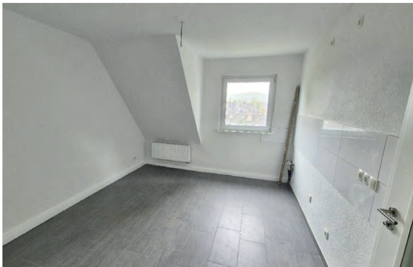
Modernisierung Liegnitzer Str. 69
