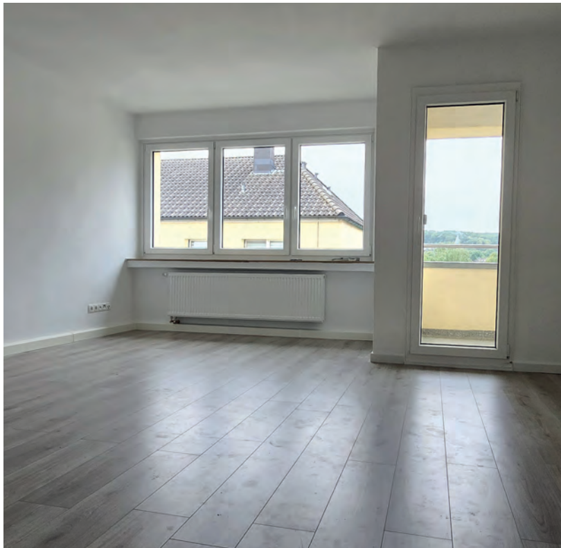
Modernisierung Meininger Str. 8
